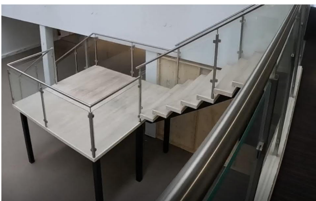
Kuva 8 Puuportaat, lasikaide ja teräskäsijohdin, purukohde (Kuva Spolia Design Oy)
