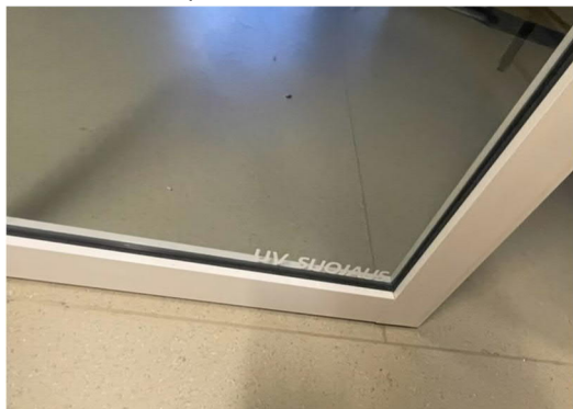
Kuva 12 Purkukohteen lasiseinäjärjestelmää (Kuva Spolia Design Oy)
