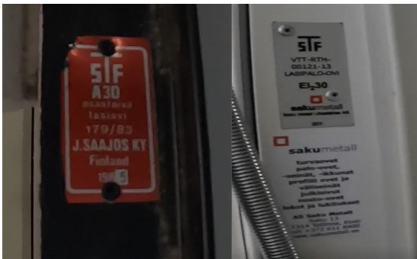
Kuva 18 Purkukohteen Saajoksen A30 lasipalo-ovi vasen kuva ja oikealla Saku Metallin sisäpalo-ovi (Kuvat Spolia Design Oy)
