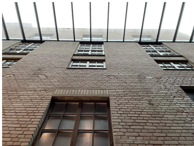
Kuva 9 Kaapelitehdas, Tanssin talo (Kuva Spolia Design Oy)
